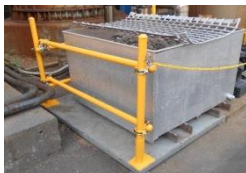
転倒防止ポール設置
